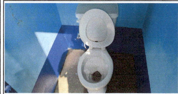
FOTO 3: sustitucion de inodoro (completo)
