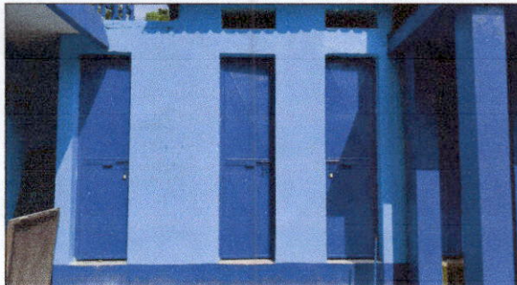
FOTO 2: Sustitucion de puerta en Servicio Sanitario
