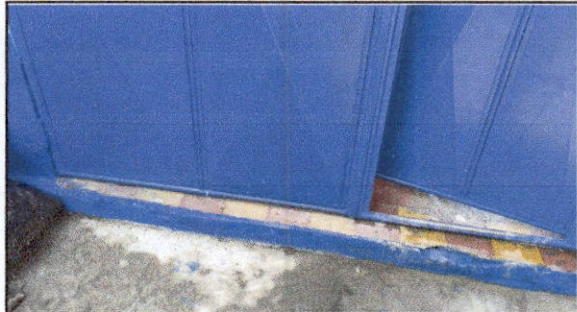
FOTO 4: reparacion de piso de concreto (entrada principal escuela)
