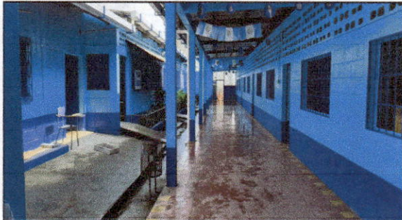
FOTO 10: Pintura en muros exteriores
