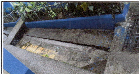
FOTO6: Sustitución de tubería PVC línea principal aguas pluviales
