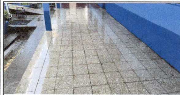
FOTO 5: Sustitución de piso de granito
