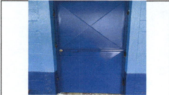
FOTO 7: sustitución de puerta de metal (incluye chapa)
